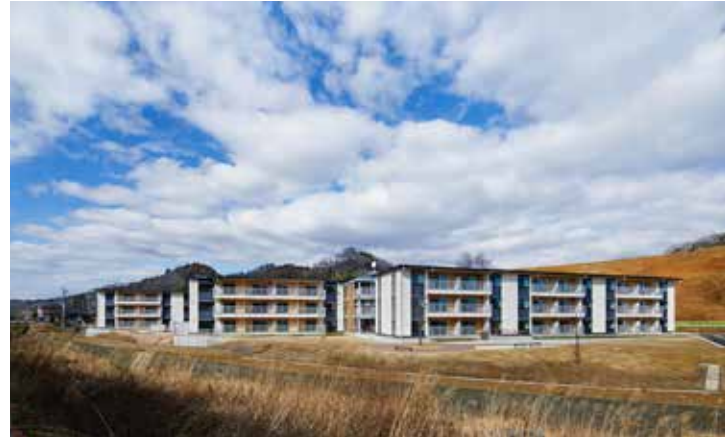
CLT構造躯体を用いた国内最大級の共同住宅
