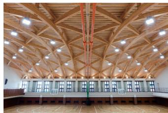
**概要** 国産材による小断面木造部材で大空間を構成する屋根の構造方法の開発。鉄骨造や鉄筋コンクリート造と同等の構造性能を確保でき、木材の軽量性を活かしヴォールト形状やドーム形状でも加工と施工で高い生産性を確保できる。実施例では、木造の暖かみのあるアリーナとなり、運動中の集中力とリラクゼーションの維持が可能となった。
