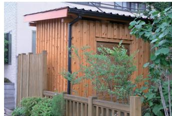
**概要** 断熱性、蓄熱効果、調湿効果、熱伝導率、肌触り、など木材の性能を最大限活かし、105角の柱を並べて非常に丈夫な壁ができる。室内用の防災用ベッドや外部用の小さな小屋や絵画などの保管庫、の利用などを想定している。DIYを通じ、木材の利用の促進やものづくりの楽しさを知っていただければと考えている。
