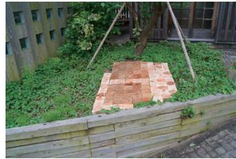
**概要** 斜地・斜面を段切りし、間伐材を使用する壁で土留めをしつつ、さながら大きな土囊状態とし、そして創出される平地には木を植えて、『木の根張りの効果』を利用して更に土囊部分を強固なものにしようという目論み。平地には間伐材タイル・カーペットを敷設する。ガーデニングなどの一般向けの施工に於いても、この工法を適用する。
