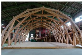
**概要** 短小の地域材を用いて、より大きな空間を構築できる構造システムを開発した。利用形態は自由であり様々の大きさの建築空間に適用できるシステムとなっている。構造体を構成する最長部材の約3倍の大きさのスパンが構築可能であると共に、既存の技術を用いて建築できるのが特徴である。
