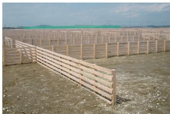
**概要** 従来の静砂垣は、接面部分が全て金具(ボルト・釘)で固定されている。海岸部に設置された状況を見ると、腐食が著しく損壊されている箇所が随所に見られる。従って現状を踏まえ何が可能か検討し、目的が達成された後の撤去及び処理等を考慮すると、木ダボ固定が木材資源の循環型利用に公益をもたらすと判断される。
